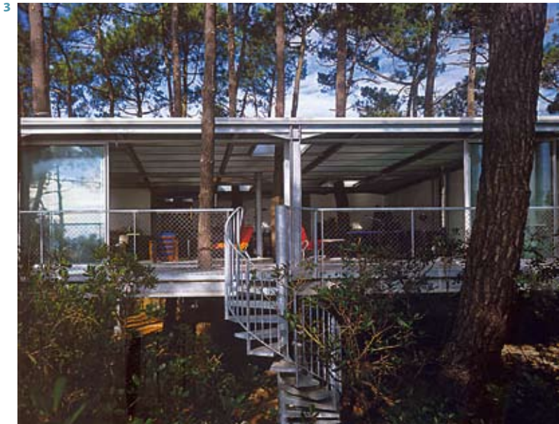
3 Edifici constructiva- ment explicit Casa a Lege (1998). Anne Lacaton & Jean- Philippe Vassal. 2G, núm. 21
