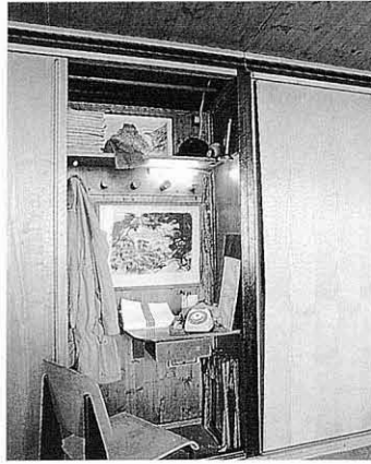
Módulo de armario, formando la pared estructura, de veintisiete metros de longitud. Foto: Olivier Henri Dancy. Cupboard Element, from the twenty-seven-metre long structural wall
