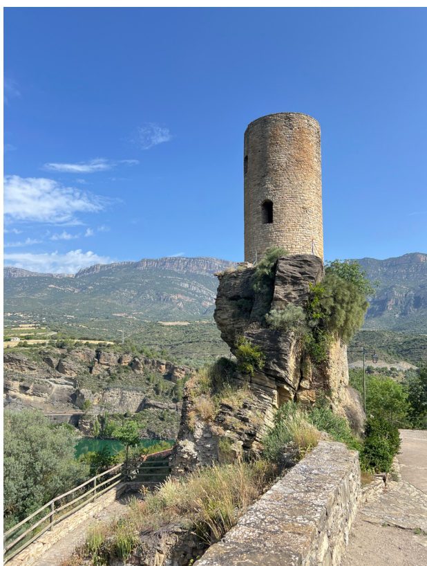
Figura 5. Torre restaurada. Conserva una altura de 14 metres.
