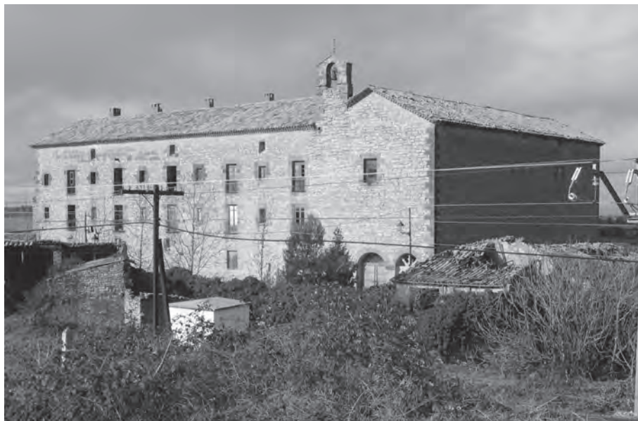
Edifici conventual dels jesuïtes i església de Sant Andreu i Sant Guim, instal·lacions que serviren per a diferents serveis, sobretot concentració de tropa, de l'Exèrcit Est durant la primavera de 1938. Foto: autor
