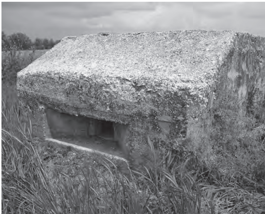
Niu blindat de formigó per fusell metrallador construït a l'alçada de les Granges del Pilar, terme de Folloleres, a uns 200 m al nord de la carretera, l'actual autovia A-II. Formava part de la línia de fortificació L-2. Foto: autor.
