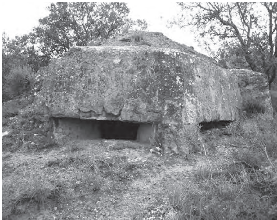
En una d'aquestes elevacions de què parlava l'informe de l'espionatge, concretament dins l'anomenat bosc de la Creueta, al nord de Muller, s'hi bastí aquesta casamata, ben camuflada, blindada de formigó i revestida amb pedra. Foto: autor.
