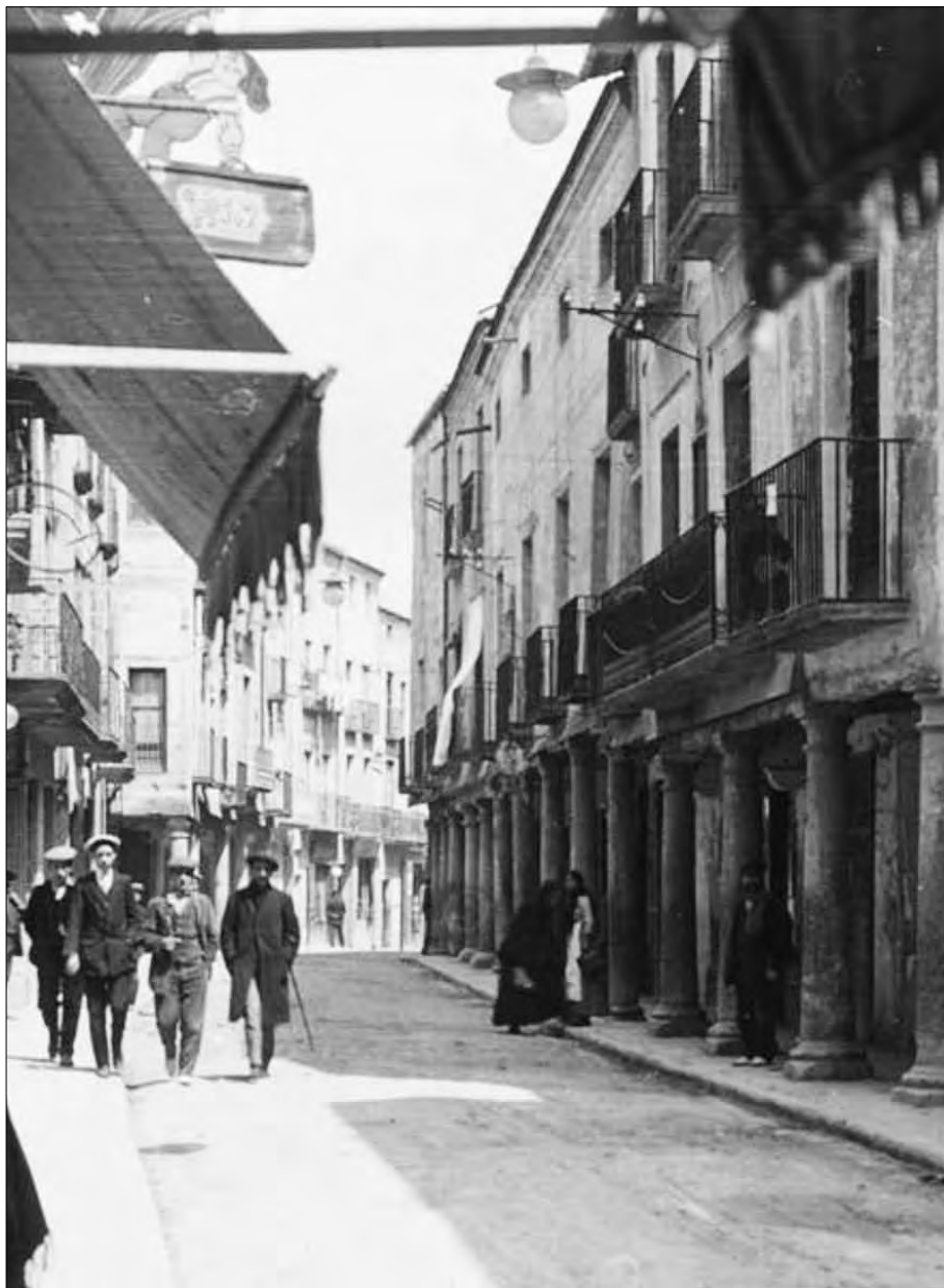
5. Carrer Major de Cervera a l'alçada de les voltes i amb els toldos de diversos comerços que palesen que es tractava de l'artèria principal de la ciutat (BNC: Fons Fotogràfic Josep Salvany i Blanch, núm. 108_01).
