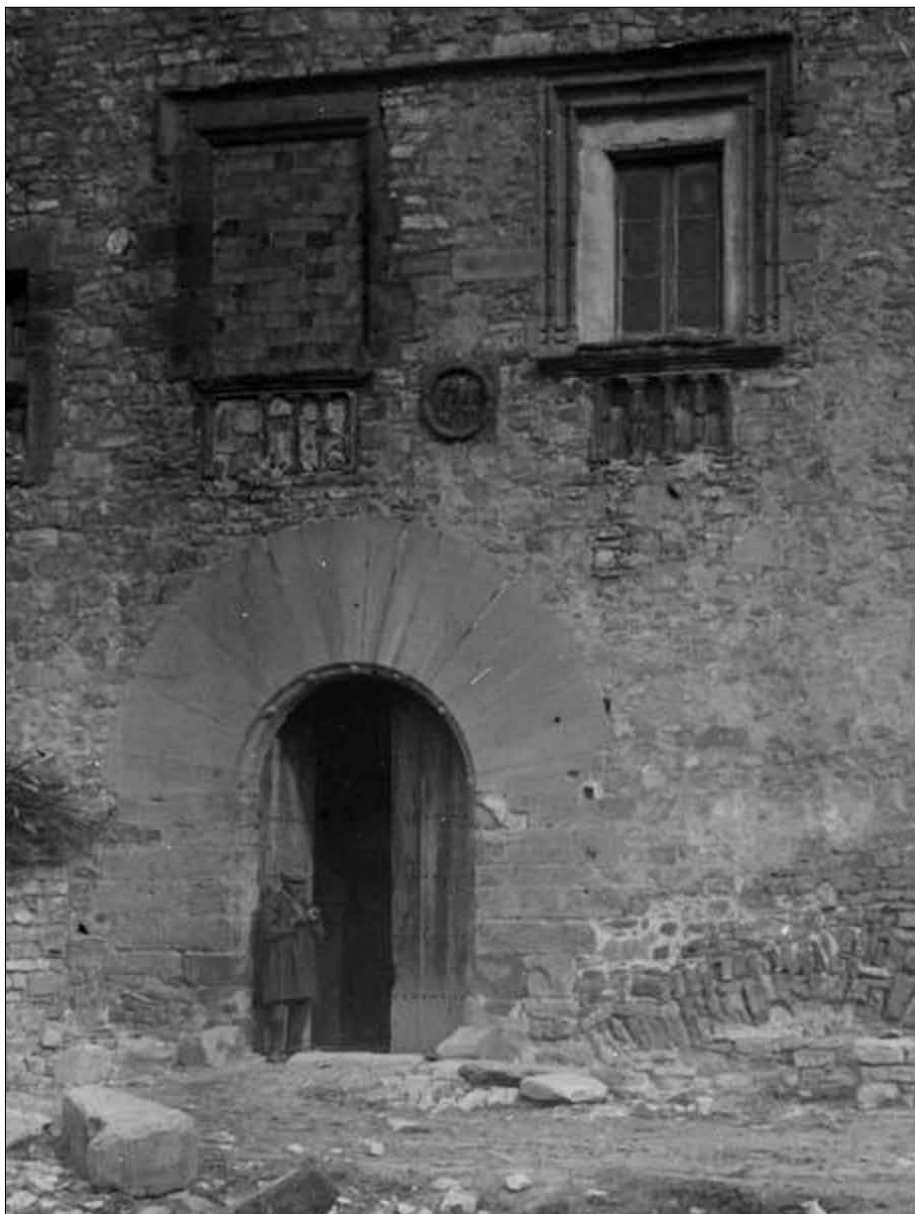
17. Castell anomenat “de dalt” –pertanyent a l’antic nucli “d’Oluja sobirana”, avui situat a la part més alta del poble de Les Oluges i convertit en una casa particular. A la imatge destaca el gran portal adovellat i les restes de finestrals del segle XVI (BNC: Fons Fotogràfic Josep Salvany i Blanch, núm. 439_02).
