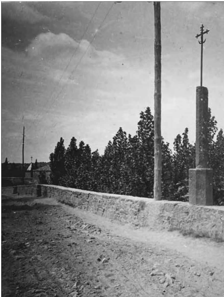
33. Creu de ferro amb fust i basament de pedra, situada a la barana del pont medieval de Sanatüja. Al fons, el nou cementiri, construït a finals del segle XIX un cop desafectat l'antic cementiri parroquial que es situava vora l'església. Per a la ubicació del nou es va escollir l'emplaçament de l'antiga capella de Santa Magdalena, situada extramurs de la Vila (BNC: Fons Fotogràfic Josep Salvany i Blanch, ).
