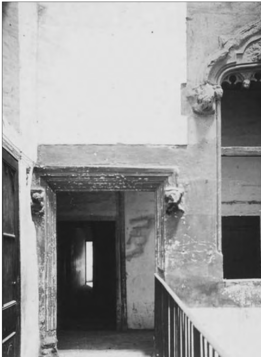
12. Interior de l'escala i accés a la planta noble de l'antic palau dels Erill (avui Ca l'Eril), a la plaça Major de Guissona, amb diversos detalls escultòrics de caràcter gòtico-renaixentista (BNC: Fons Fotogràfic Josep Salvany i Blanch, núm. 435_03).
