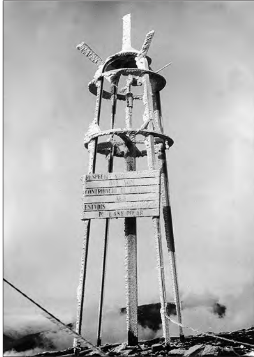
Fig. 8. Anemòmetre protegit dels llamps a l'observatori del Turó de l'Home, instal·lat en el marc del Segon Any Polar Internacional (fons família Dr. Jardí)
