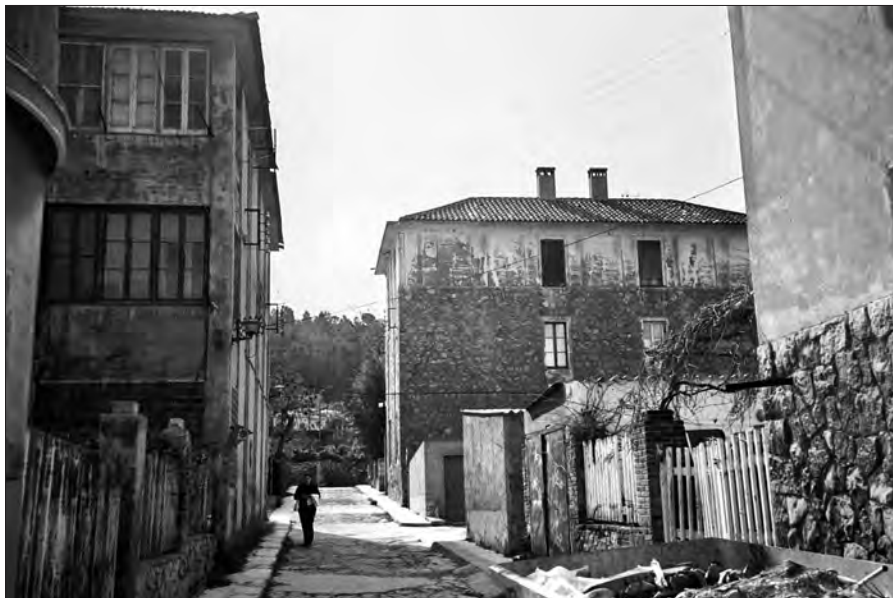
Fig. 3. Detall d'un dels carrers de la Colònia on s'aprecia un deteriorament general (2005)
