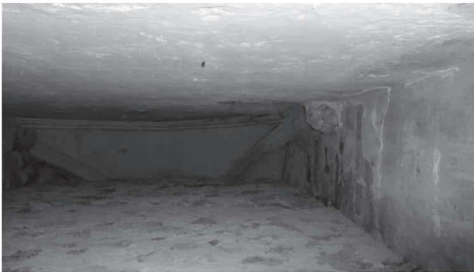
Fig. 9. Arrendament de la volta de creueria, coincidint amb la capella de l'esquerra (Foto: Jordi Marquès Ariño).
