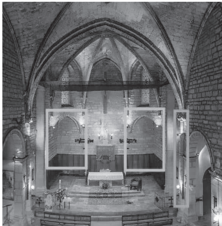
Fig. 3. Vista del presbiteri. Es remarquen les dues voltes raconeres i el pilar del primer tram de la nau (Foto: Jordi Marquès Ariño).
