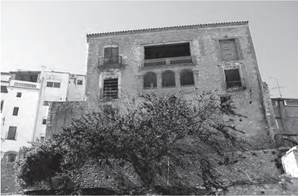
Fig. 4. Façana sobre el riu Ebre a Cal Cavaller d'Ascó. Foto cedida per Biel Pubill
