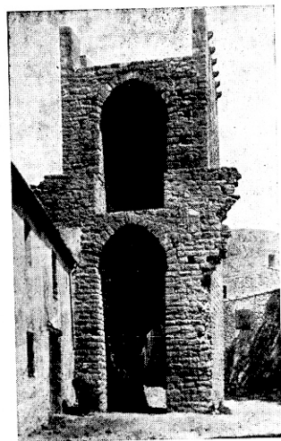
Portal de Santa Catalina, una de las torres del recinto amurallado medieval.
