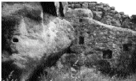
Forats excavats a la vertical de la cinglera
