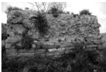
Detall d'un dels murs externs on s'observa el basament de pedra i el mur superior amb l'argamassat descrit
