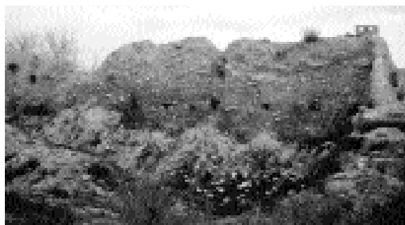
Aspecte actual dels murs de la primitiva torre
