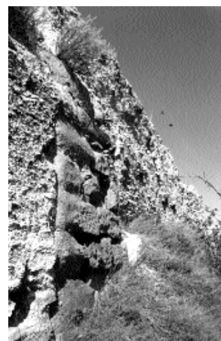
Vista parcial de les restes dels murs d'aquest primitiu edifici religiós
