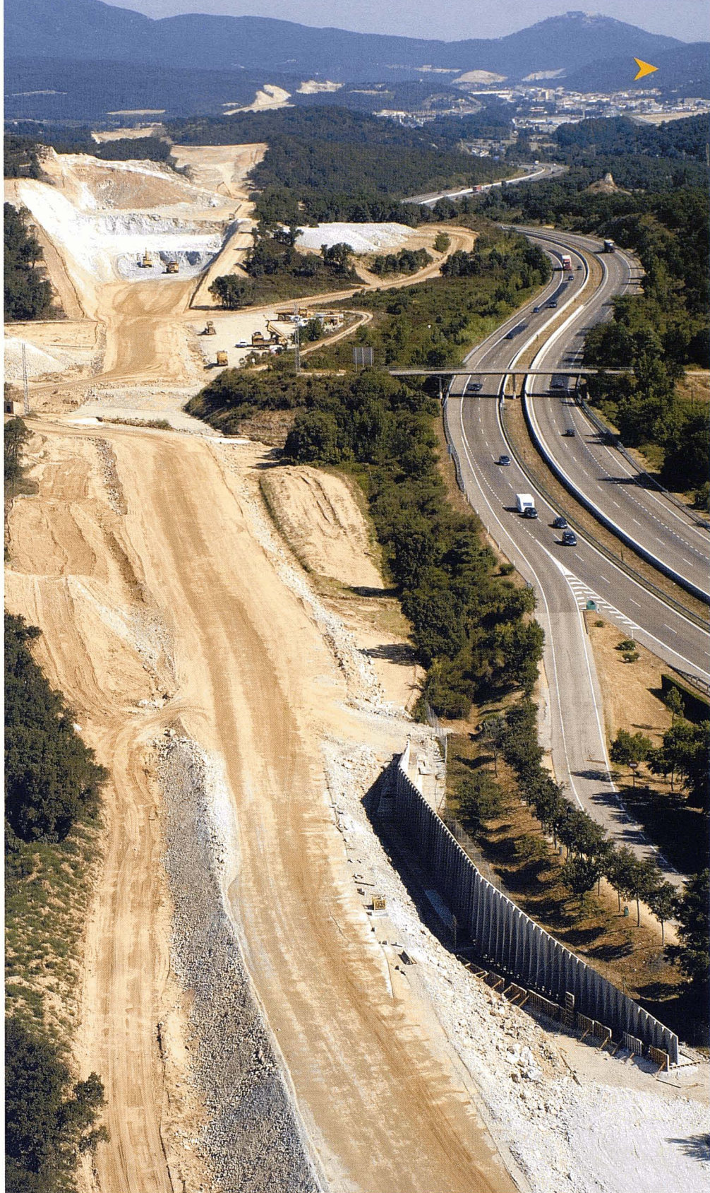
Obres de construcció de la traça del viaducte. TP Ferro Concessionària, S.A.
