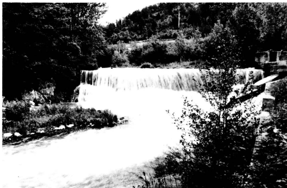
La resclosa de Terradellas al Bastareny és un exemple de l'aprofitament hidràulic del Llobregat i els seus afluents. RIBERA
