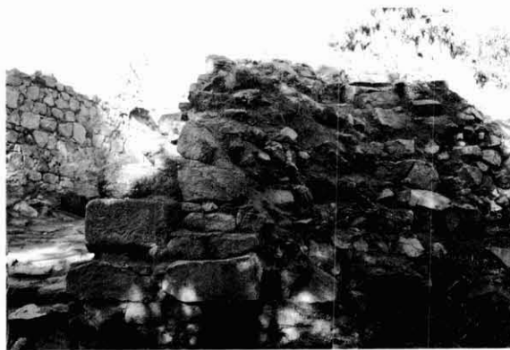
Figura 10. Vista de la fachada del pasadizo y del relleno interno de la obra: Muro 45 (Fase 1b).
