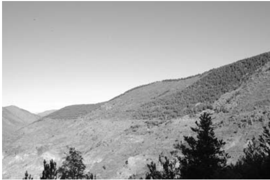
Fig. 13. Bosque de protección contra los aludes, su finalidad es la retención del manto nivoso en una zona de salida.
