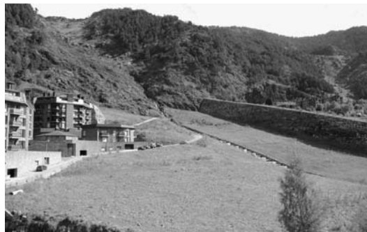
Fig. 12. Dique lateral de frenado acompañado de una gran depresión destinada a almacenar la nieve que baja del alud.
