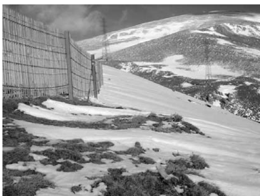
Fig. 17. Paravientos de láminas verticales de castaño. Observar los depósitos de nieve a sotavento.
