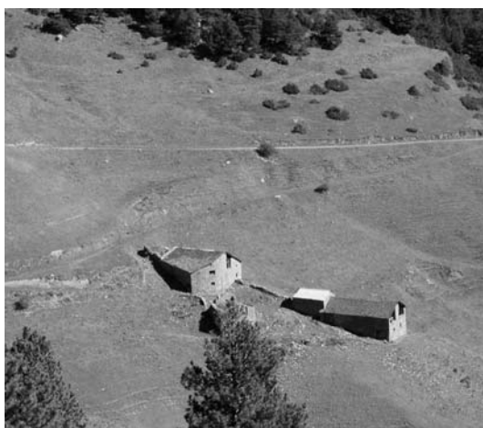
Fig. 11. Corral situado en una zona de aludes. La parte del corral orientada hacia arriba se ha construido en forma de cuña, se trata de una desviación lateral doble.
