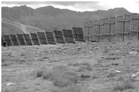
Fig. 16. Paravientos con tablas verticales.
