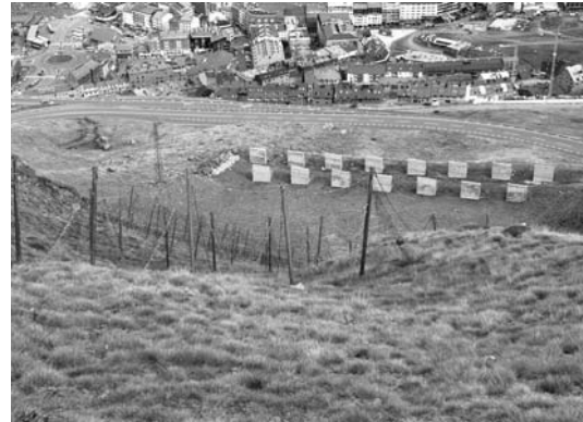
Fig. 15) Zona de aludes vista desde su parte superior. En primer término (dentro de la zona de salida) aparecen unas redes, más abajo rastrillos, y en último término en la zona de llegada, dientes de frenado.
