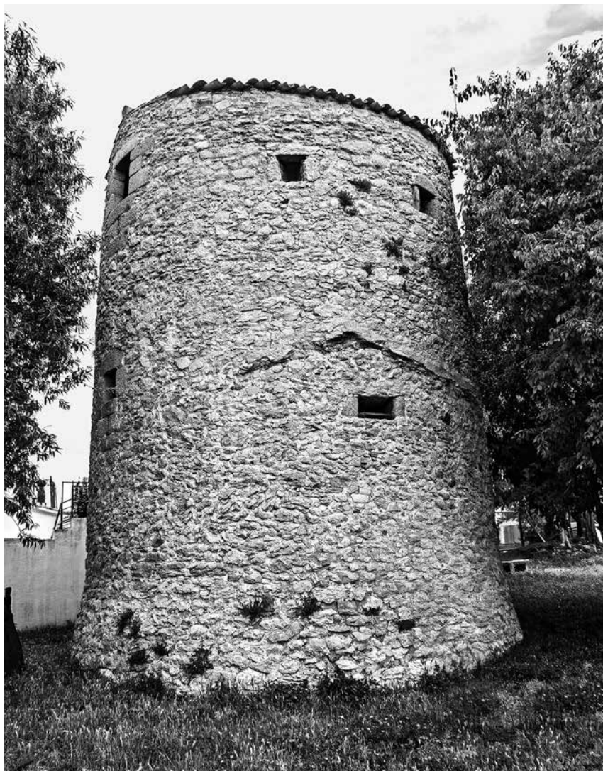
Fig. 10. La torre de Vila-seca. Fotografia: Lluís Maimí.
