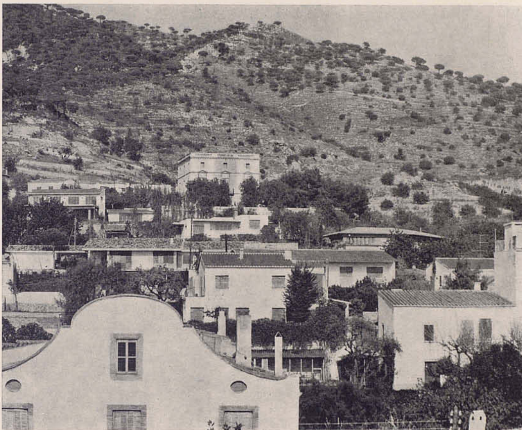
Vista general del emplazamiento de la obra.
