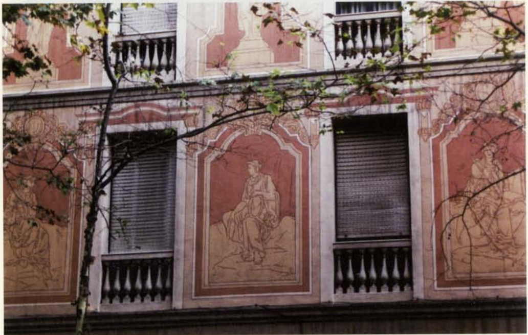
Fig. 16. La mateixa personificació està representada a l'altra casa, concretament al primer pis de la façana de Roger de Llúria (foto A. López Mullor, 2002).
