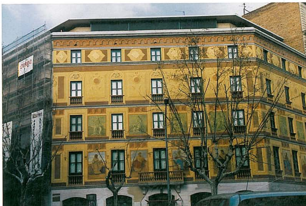
Fig. 2. Vista de la casa amb dues de les façanes ja restaurades (foto A. López Mullor, 2003).
