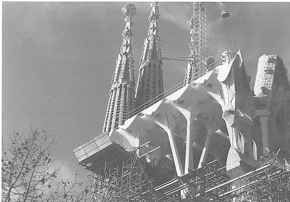
Part de les voltes construïdes (tardor 1995)
