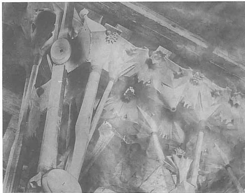
Model original de Gaudí, a escala 1/10 de les voltes amb les columnes de suport.
