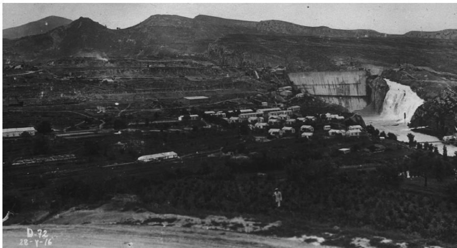
La presa de l'embassament de Talarn en la fase final de les obres de construcció. Al costat, el campament de Sant Antoni destinat a l'allotjament de part dels treballadors (28-V-1916). Arxiu Izard Forrellad. Lleida.
