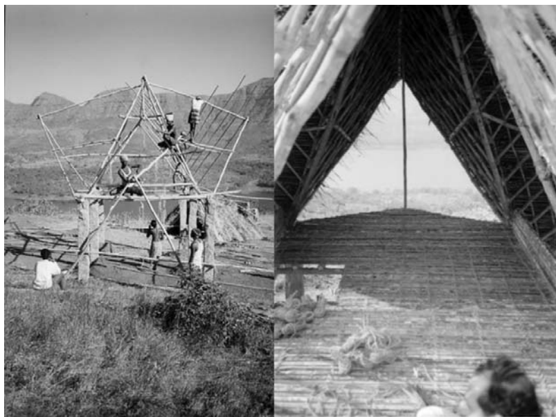
Anupama Kundoo, Construcción de Palkhiwalas
