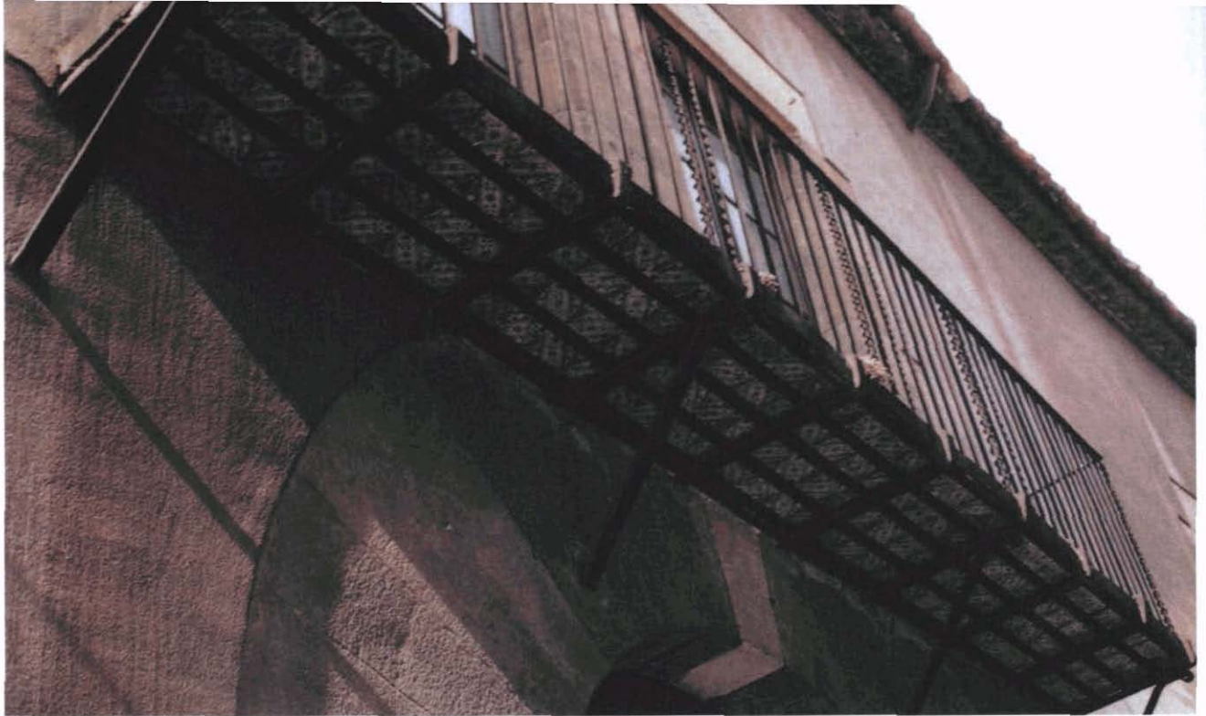
Fotografia 1. A Sabadell trobem un exemple molt significatiu de rajoles sota el balcó del segle XVIII de la Casa Duran, emblemàtica casa pairal de la nostra ciutat construïda al segle XVI i reformada al segle XVIII. Autores: Marta Bertran i Mercè López (MHS), 2001.
