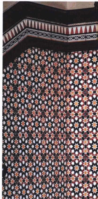
Fotografia 14. Com a exemple d'un disseny d'inspiració àrab volem destacar l'arrimador del cancell de la casa Brujas (c. de la Creueta), construïda per Miquel Pascual i Tintorer el 1888. Es tracta d'un model únic a la nostra ciutat i destaca per una gran bellesa i un molt bon estat de conservació. Autores: Marta Bertran i Mercè López (MHS), 2001.
