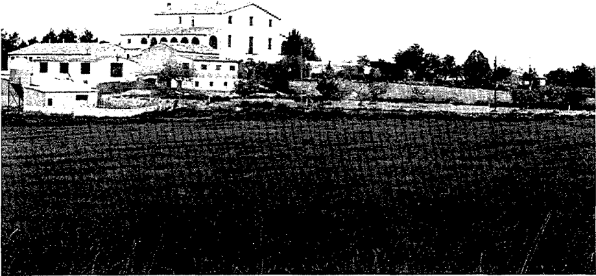
La Torre de Ferran; Municipi d'Argensola
