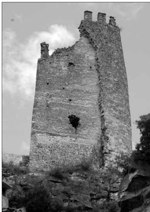
Figura 10: torre de Santa Perpètua de Gaià abans dels treballs de consolidació.
