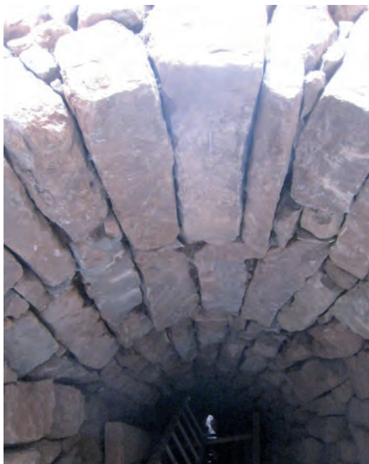
Detall d'un tram de volta restaurada amb la tècnica de la pedra en sec (J. Morros)
