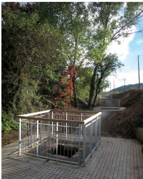
Aspecte de l'estat final de l'acabat exterior dels pous de ventilació (J. Morros)
