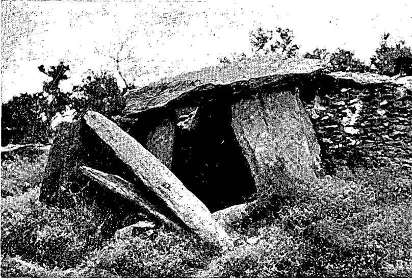
1 El dolmen de La Creu d'en Cobertella antes de la restauración. Obsérvense los restos de la piedra D.
