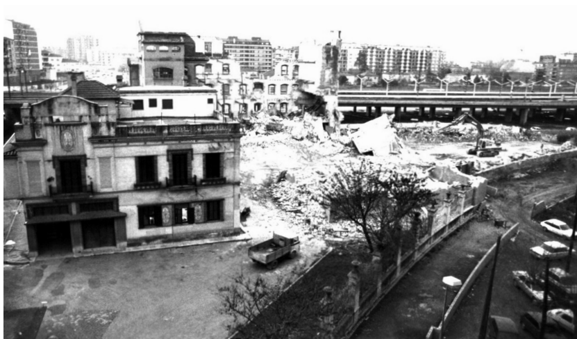
Fig. 5. Imatge presa durant l'enderroc dels edificis auxiliars de la Farinera Montserrat. 1988. (Fotografia: David Quintana. Ajuntament de Girona. CRDI. R.204658).
