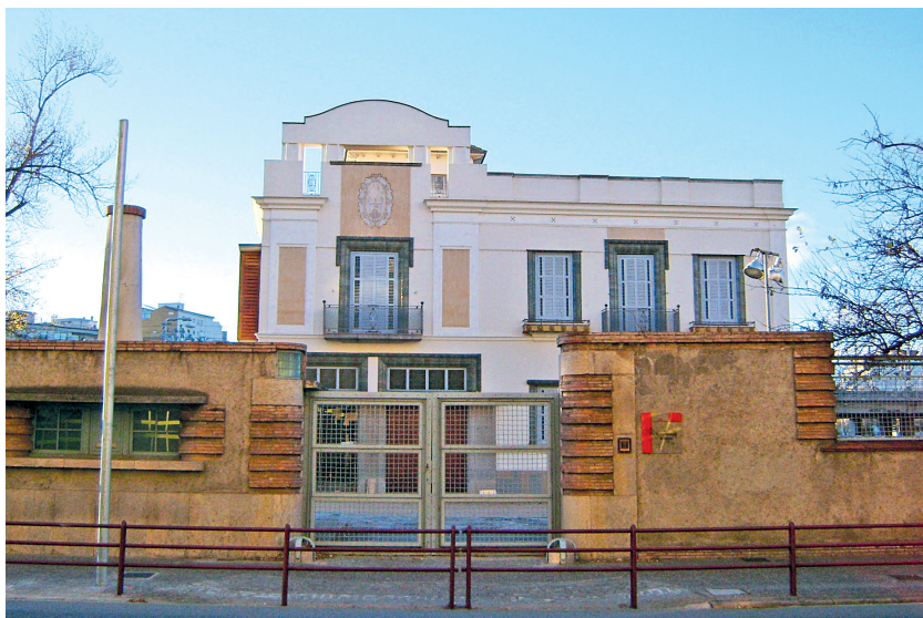
Fig. 6. Vista actual de la Casa Ensesa (Fotografia de les autores).
