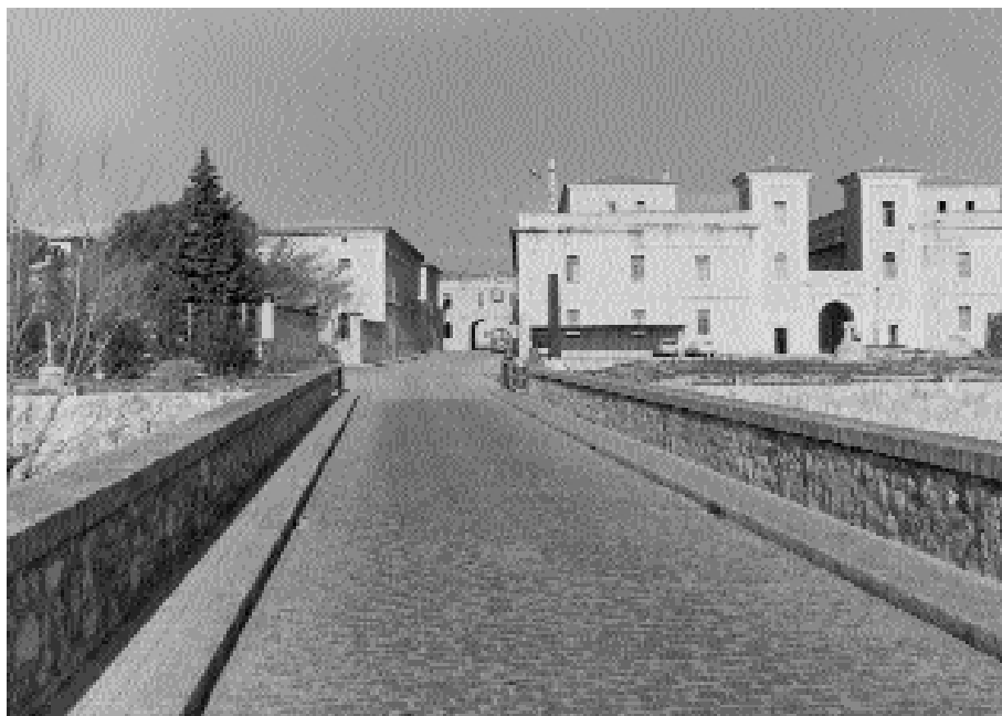
Figura 9. Aspecte actual de la façana sud del recinte interior. A l'esquerra, la clínica i, a la dreta, l'arsenal, amb els pavellons i les torres d'accés segons el Projecte Velasco. (Fotografia de l'any 1980).
