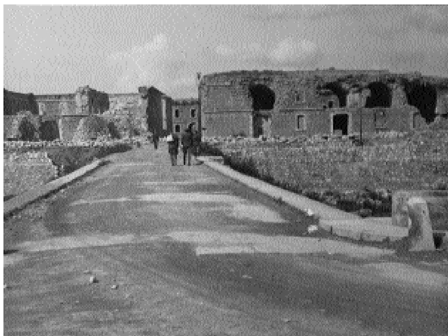
Figura 5. Estat de la cortina sud a finals del 1941, iniciades ja les obres de la clínica (esquerra) i l'escarpa; a la dreta, l'arsenal mostra els senyals de la voladora.
