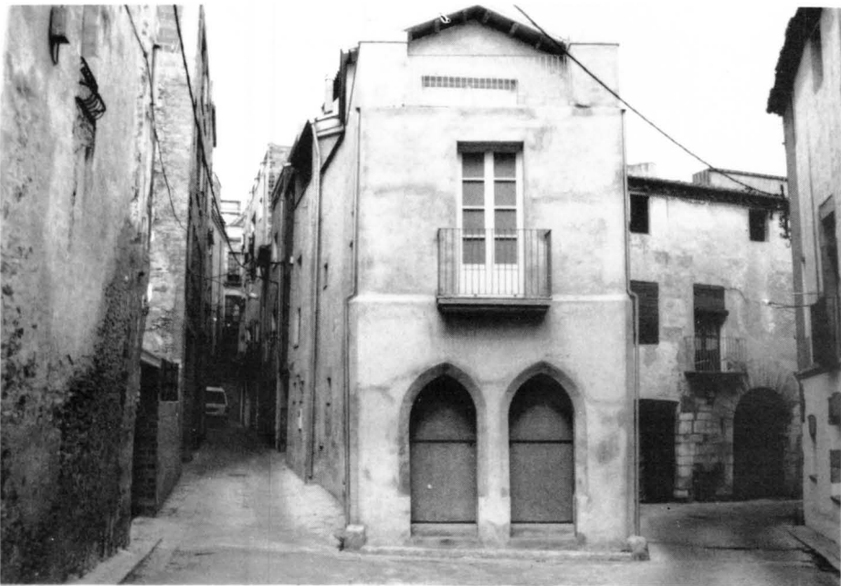
Plaça de les Peixateries Velles. A primer pla, l'edifici de les antigues peixateries. Al fons, a mà dreta, la Sinagoga del puig del Mercadal.
