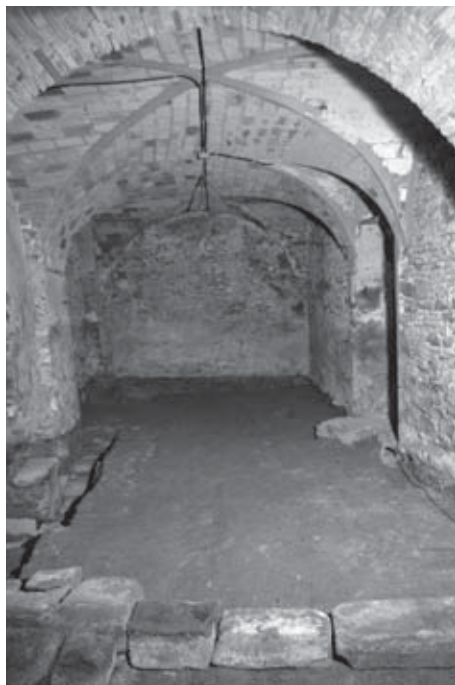
Figura 18. Vista actual de la sala, presa des del sud, amb els arcs i les voltes del tipus català de llunetes.
