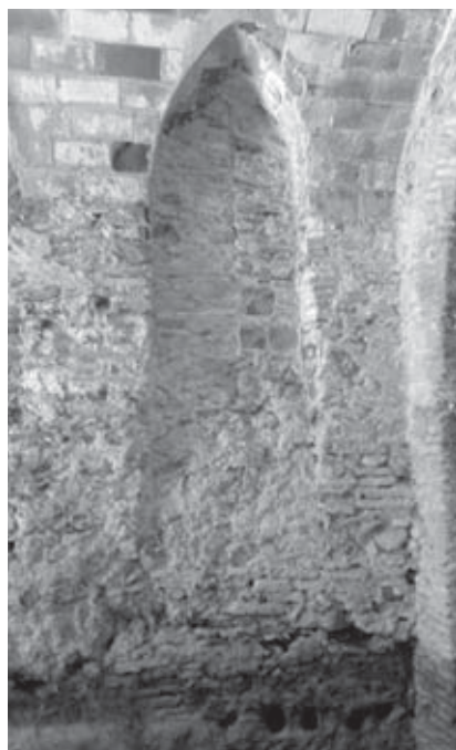
Figura 16. Imatge de l'obertura, avui tapiada, que permetria l'accés entre el dipòsit gran i la casa annexa a l'oest.
